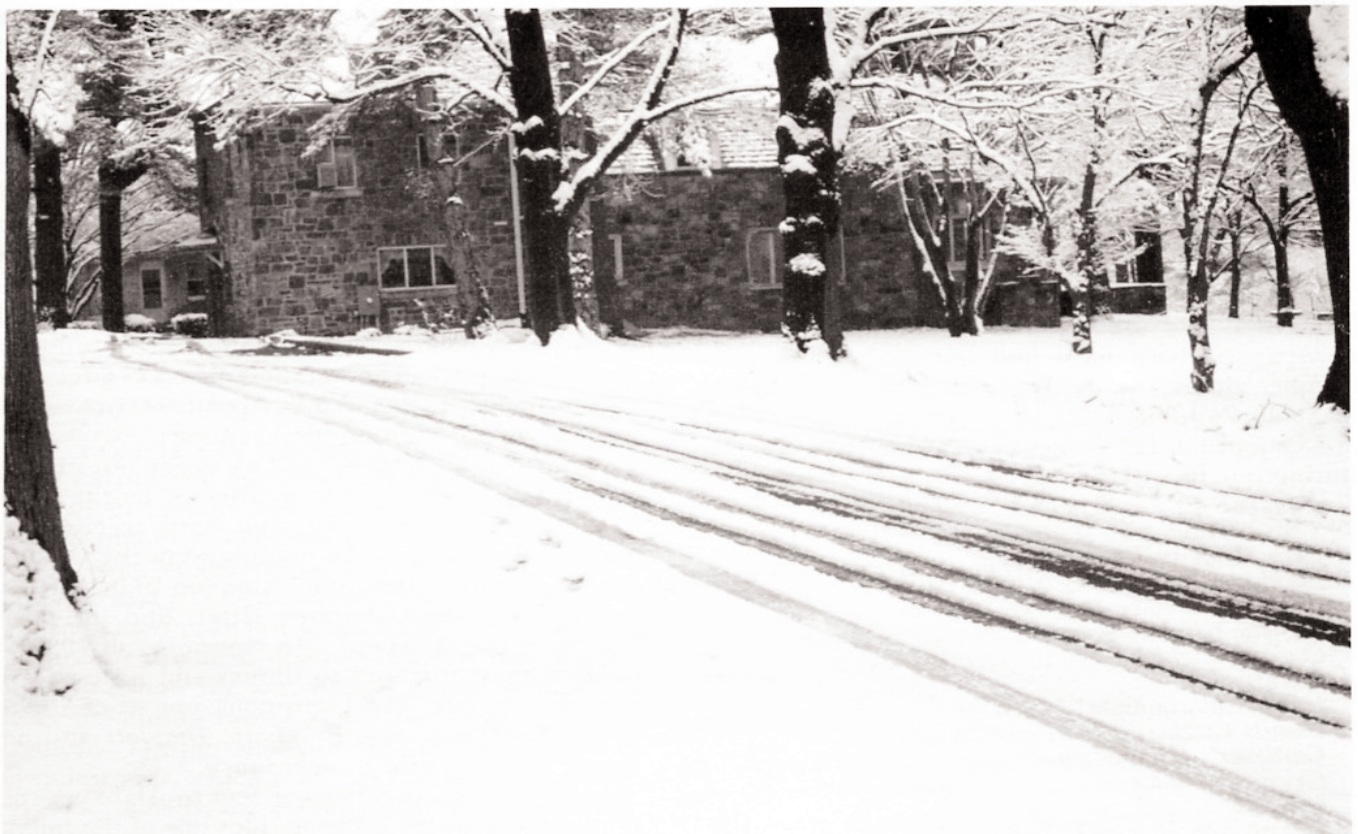
Hauptzufahrtsstraße zum Bibelhaus; die zwei Räume links sind die Küche; der Raum rechts der Essenraum; die Schlafräume im zweiten Stock
