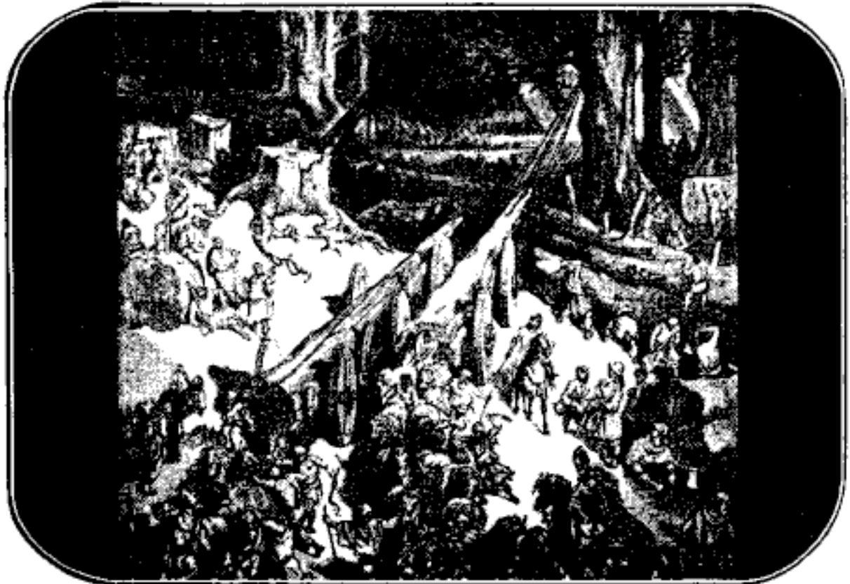
Das Fällen des Tempel-Bauholzes.
